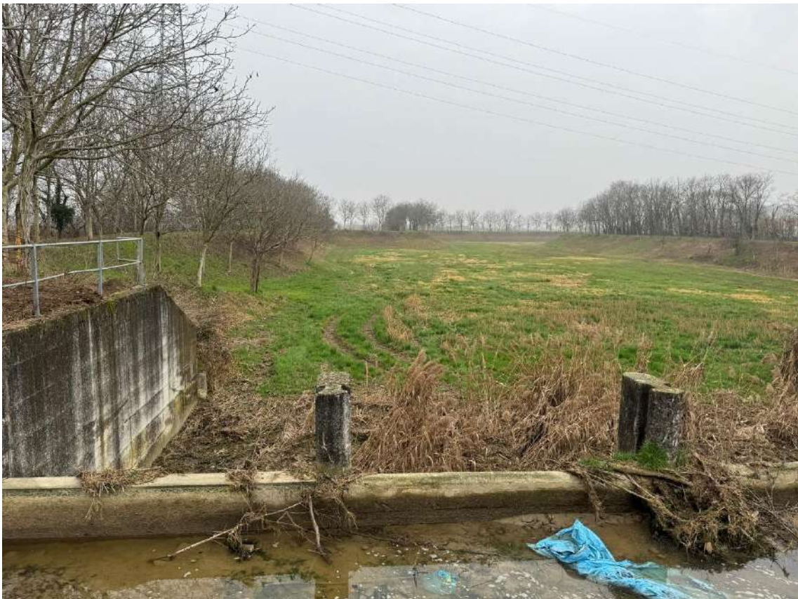
Foto 14 - Cassa di espansione da nord
