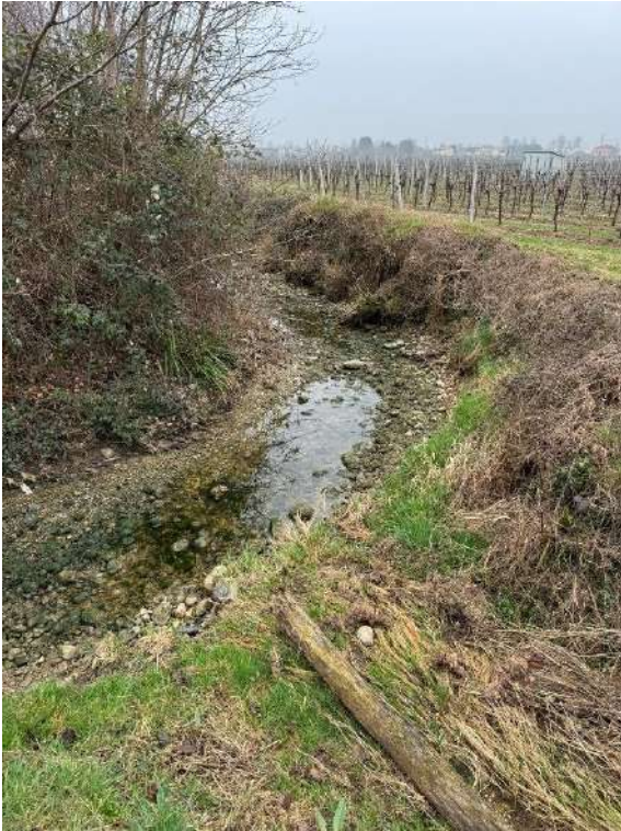
Foto 15 - Canale Ca'Mula a ovest della cassa di espansione
