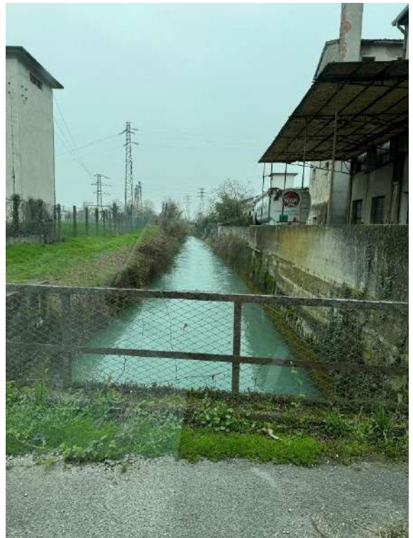
Foto 41- C. di Caerano su via Palladio verso monte
