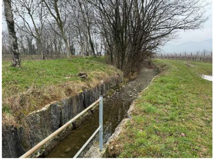
Foto 13- Canale Ca'Mula a valle ingresso cassa espansione
