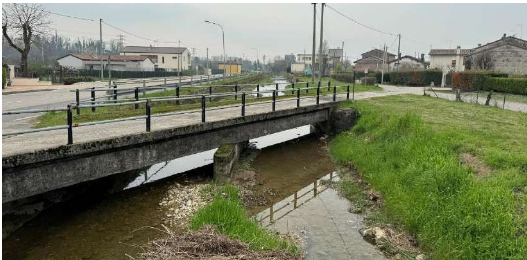
Foto 37– Ponte sul Canale di Caerano via Lavaggio - via Piave
