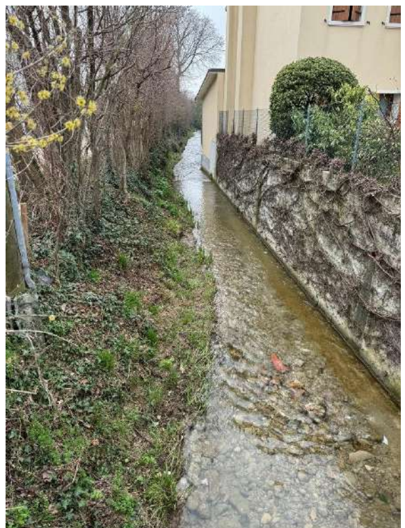
Foto 26- Canale Ca'Mula in via Tiziano verso valle
