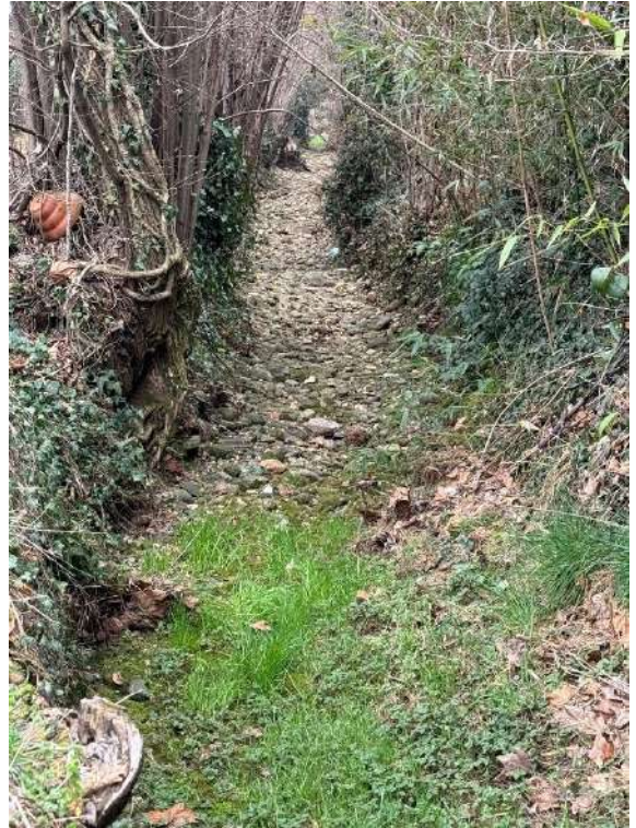
Foto 6- Canale Ca'Mula in via Muliparte verso valle
