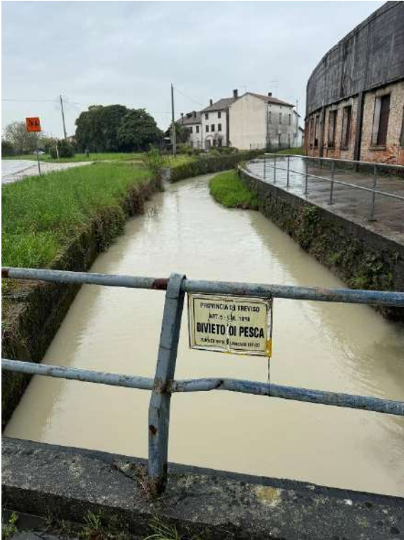
Foto 54 - C. di Caerano dal ponte di v. Mazzini verso monte
