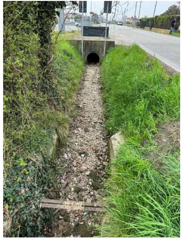
Foto 32 – Fossato lato sud di via Mure
