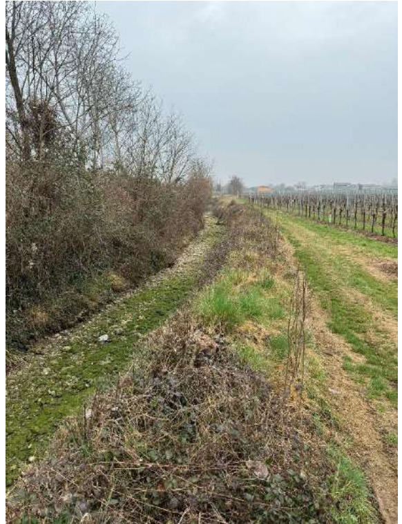
Foto 16- Canale Ca'Mula a ovest della cassa di espansione
