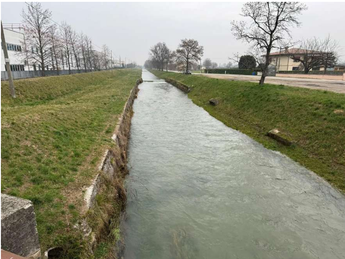
Foto 33 – Canale di Caerano dal ponte di via Piave verso monte
