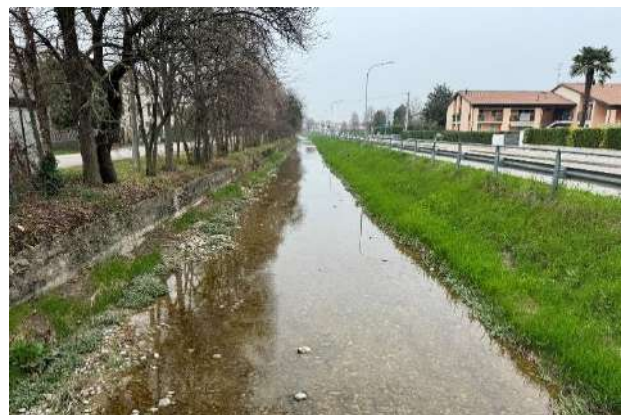
Foto 36– C. di Caerano dal ponte di via Lavaggio verso monte
