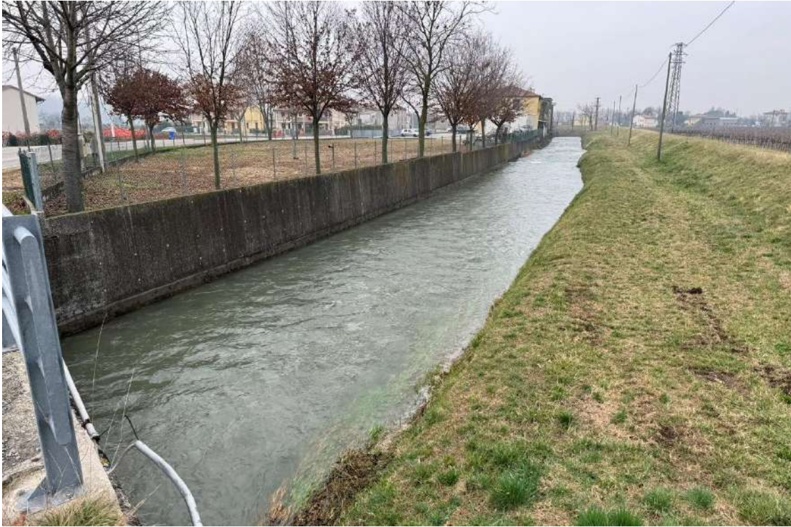
Foto 34– Canale di Caerano dal ponte di via Piave verso valle
